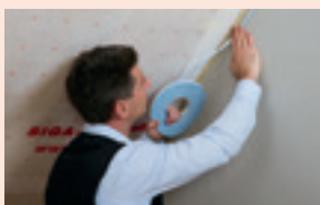
Frein-vapeur sur mur de construction massive
