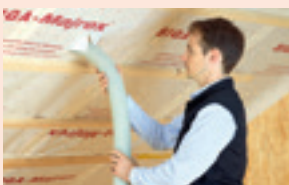
Montage d'un frein-vapeur en cas d'isolation par insufflation
