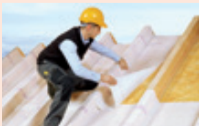
Montage d'un frein-vapeur lors d'un assainissement de toiture par l'extérieur
