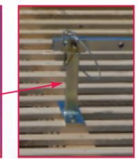
Prévoir la fixation par 4 vis torx ø 6 x 60 mm
