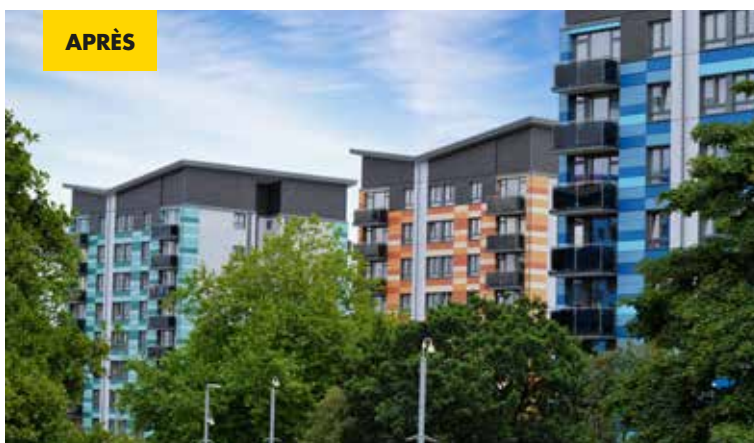
RÉFECTION DU REVÊTEMENT DE FAÇADE, CHARLEMONT FARM ESTATE, ROYAUME-UNI.
