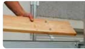
plinte latérale à installer sur le plancher
