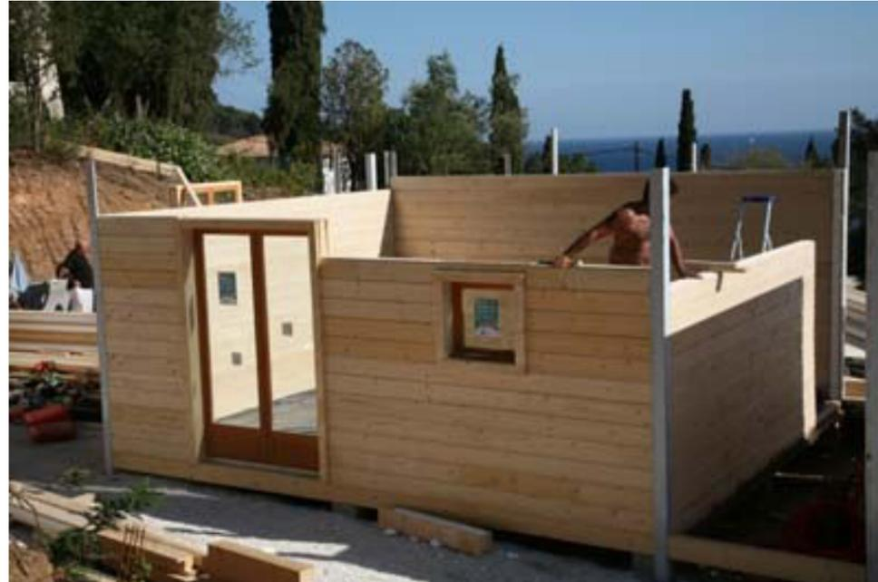
Procédé de madrier à isolation intégrée constitué de **deux parois minces préfabriquées en bois d'épaisseur 35 mm**, maintenues espacées par un isolant haute densité et servant de paroi prête à l'emploi, pour la réalisation de murs, planchers ou plafonds.
