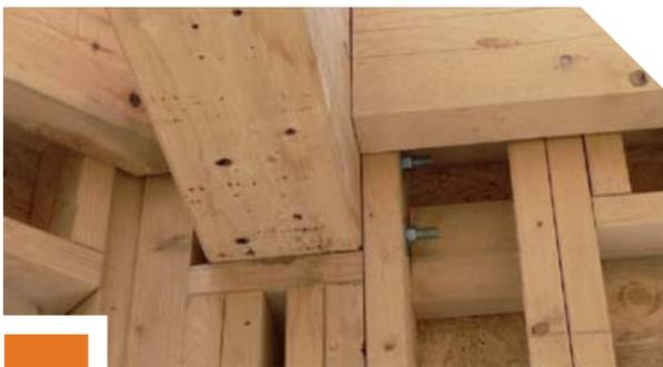
Descente de charge poutre sur mur façade
