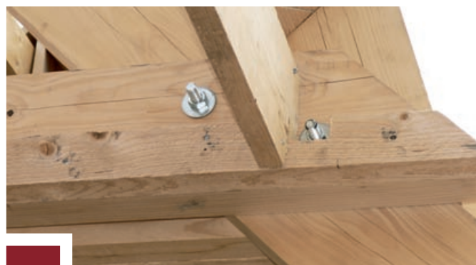
Assemblage entrain retourné-arbalétrier
