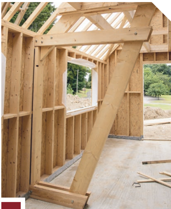
Pied de ferme sur dalle béton
