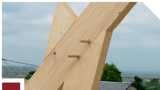
Assemblage arbalétrier-jambe de force et échantignole
