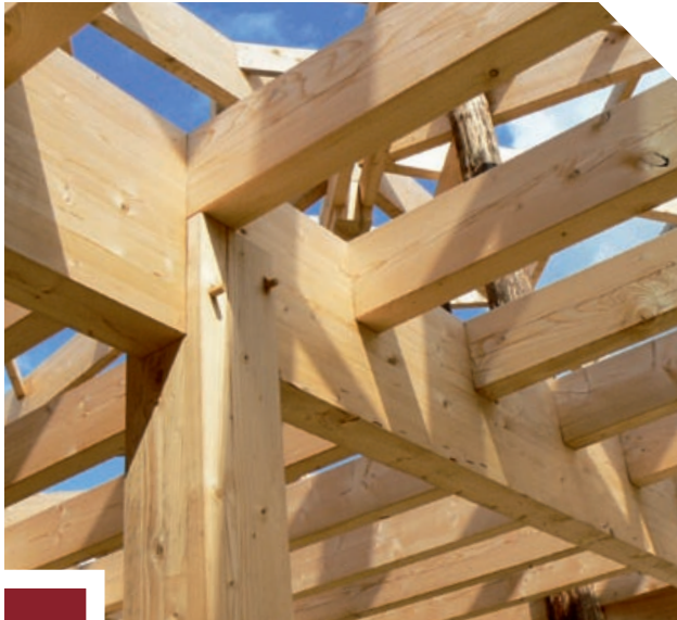
Poutre, poteau et solivage à queue d'aronde
