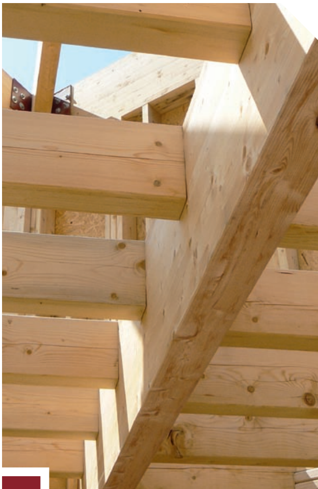
Solivage avec assemblage en queue d'aronde (pour plancher apparent)
