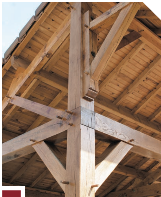
Détail des assemblages
