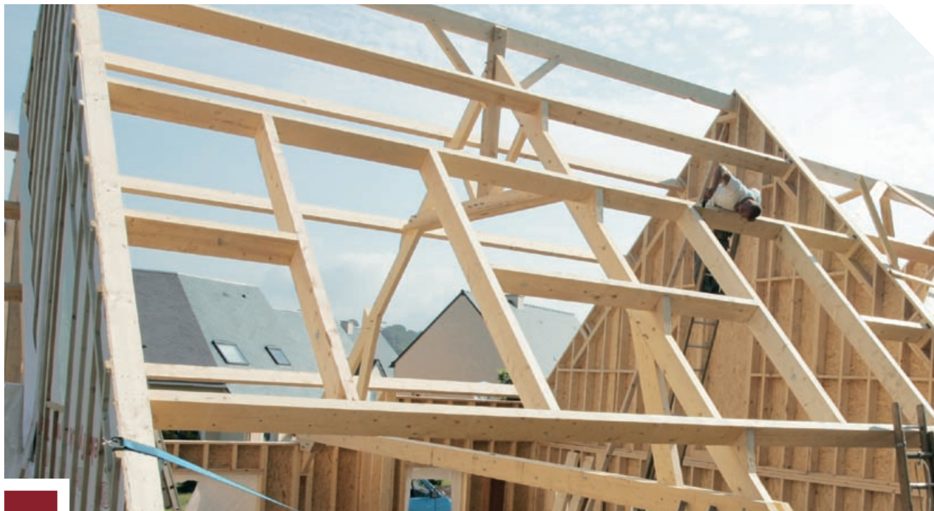
Ferme pour comble aménageable avec entrain porteur
