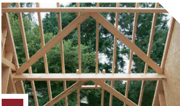
Pannes avec appuis sur mur et bracons
