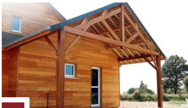
Ferme pour comble perdu avec poteau
