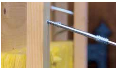
En habillage de mur avec isolant.
