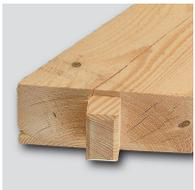
Pour réaliser des tenons en biais, il suffit d'incliner l'unité de fraisage.
