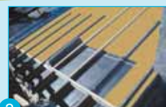
3 Déroulement du revêtement d'étanchéité sur les tasseaux trapézoïdaux.
