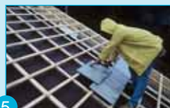
5 Pose de la couverture.
