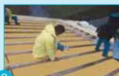
2 Fixation des tasseaux trapézoïdaux au droit de chaque chevron.
