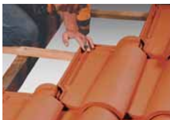
Fixation des tuiles en plain carré pour tenue au vent par vis et rondelle d'étanchéité.
