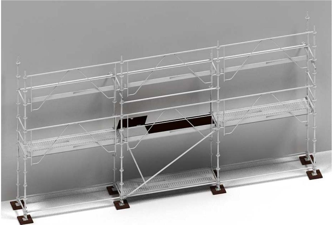
**11. mettre en place le premier niveau de planchers ainsi que les moyens d'accès (plancher à trappe) ne pas oublier les verrous de plancher.**
