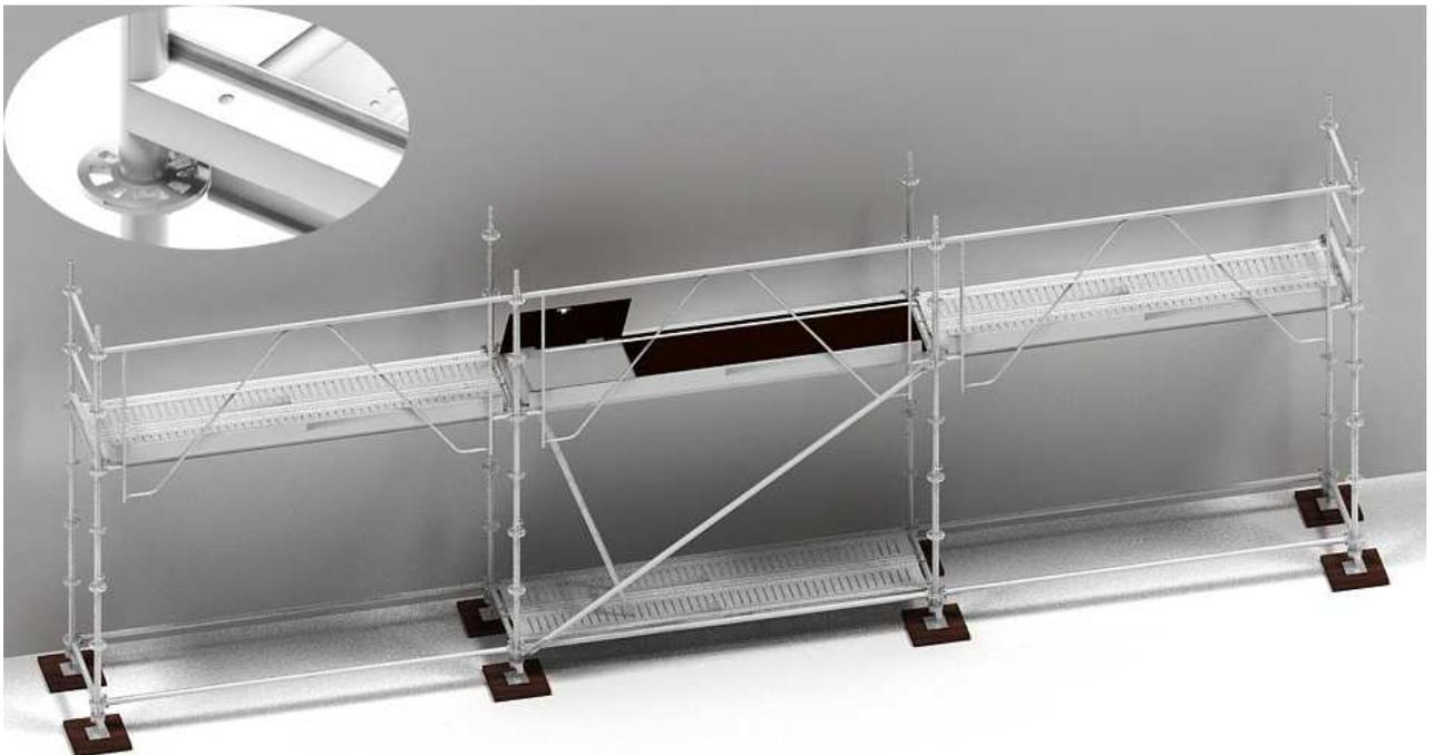
9. Continuer l'élévation de votre structure en respectant les étapes précédentes. Pour le niveau de terminaison, remplacer les poteaux 2m intérieurs par les poteaux de 1m.
