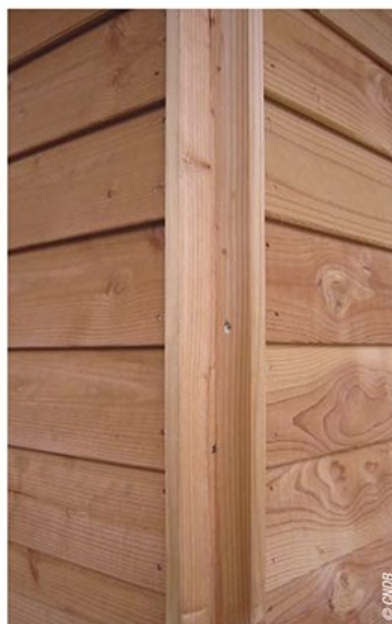
Un profil en bois sert comme angle sortant et protège en même temps les lames aboutées des intempéries.
