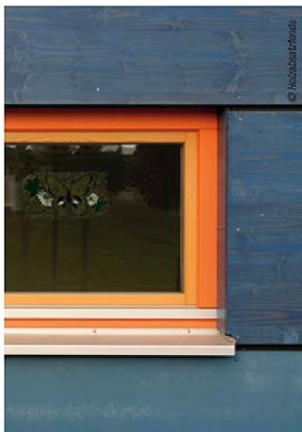
Les panneaux ont été coupés en fonction de la hauteur des fenêtres et rythment parfaitement la façade.
