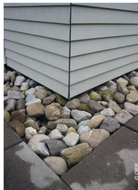
Lames horizontales aboutées avec joint de ventilation.
