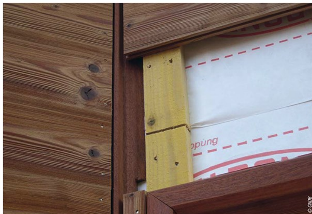
Angle rentrant avec un profil bois adapté à la pose du bardage en atelier.
