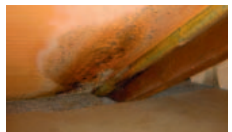
Etanchéité à l'air défaillante au niveau du plancher de combles non aménagés : condensation dans les rampants.
