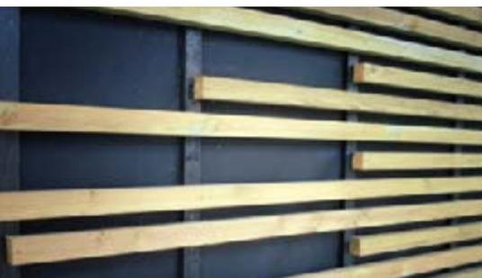
Le recours à des bardages à claire-voie est de plus en plus répandu et offre de nouvelles perspectives architecturales. Ce type constructif entraîne cependant des exigences renforcées pour le pare-pluie, en particulier pour ce qui concerne sa stabilité aux UV. Les pare-pluie DELTA® destinés à être mis en œuvre derrière bardage à claire-voie satisfont au test de vieillissement spécifique de la norme EN 13859-2 (5.000 h UV au lieu des 336 h pour les écrans traditionnels).
