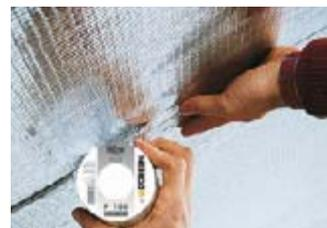
Ruban adhésif aluminisé pour coller la face supérieure de DELTA®-REFLEX dans la zone de chevauchements et la réparation des petites fissures.
