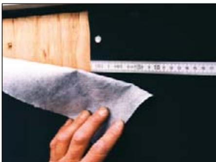
Les angles d'ébrasement de menuiseries extérieures seront recouverts par retour du pare-pluie et réalisés de telle manière à dévier vers l'extérieur les éventuelles infiltrations d'humidité. Pour le traitement des différents points singuliers (sorties de conduit de ventilation, menuiseries extérieures, gaines techniques), le collage
