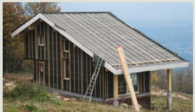
Le pare-pluie est en général déroulé horizontalement sur la paroi puis fixé provisoirement sur le support (montants ou panneau de contreventement) par des pointes ou des agrafes. Le maintien définitif sera assuré par des tasseaux fixés dans les montants de l'ossature. Dans le cas de la mise en oeuvre sur panneau de contreventement, la fixation sera de préférence réalisée sous le tasseau ou au niveau d'un recouvrement, de manière à éviter toute perforation non recouverte.
