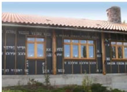
Les parois d'une MOB sont en général constituées d'une structure principale avec montants espacés d'env. 40 à 60 cm, d'une isolation thermique dans les vides (éventuellement associée à un complément d'isolant intérieur ou extérieur), d'un panneau de contreventement intérieur ou extérieur, d'un habillage intérieur et d'un parement extérieur (bardage bois, brique, pierre, ...).
