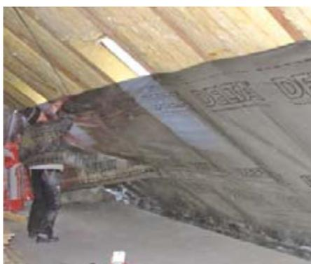
Le pare-vapeur est fixé par agrafage sous les chevrons et appliqué directement au contact de l'isolation thermique. Le maintien définitif de la membrane est obtenu par application d'un contrelattage.
